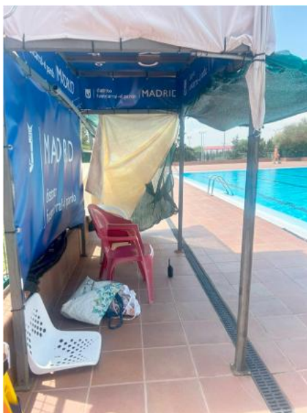
Carpa improvisada con telas y mallas remendadas
