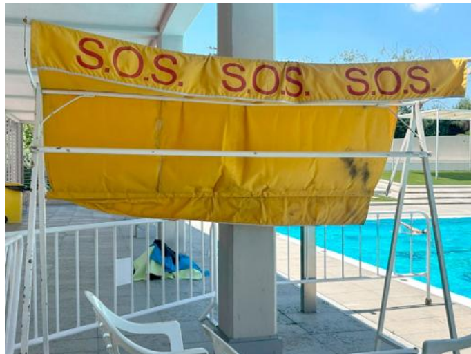
Toldo de vigilancia deteriorado, sucio y con la estructura oxidada.
