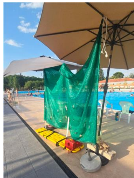
Malla de sombreado rota, atada con cuerdas y sujeta con bloques de hormigón.
